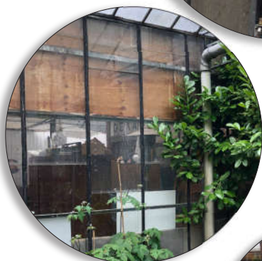
Huidige staat van de gevel
