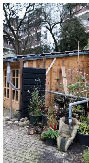
Regenschutting met overloop
