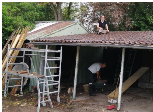
Renovatie schuur met tweedehands bekistingshout en restanten dakpannen
